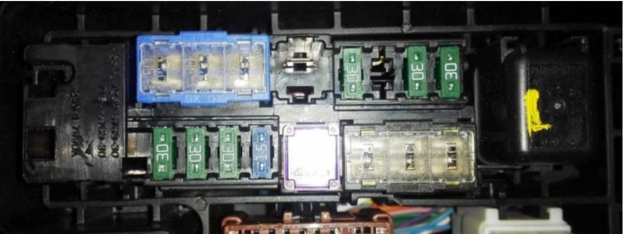
Photo du 2ème bloc de montage
