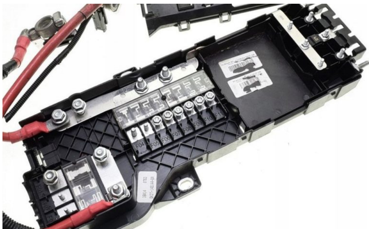
Photo - exemple d'exécution
